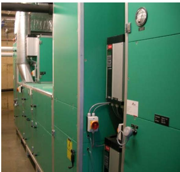
Zentrale Luftaufbereitung. Drehzahlregelung aufgrund der Druckverhältnisse.
