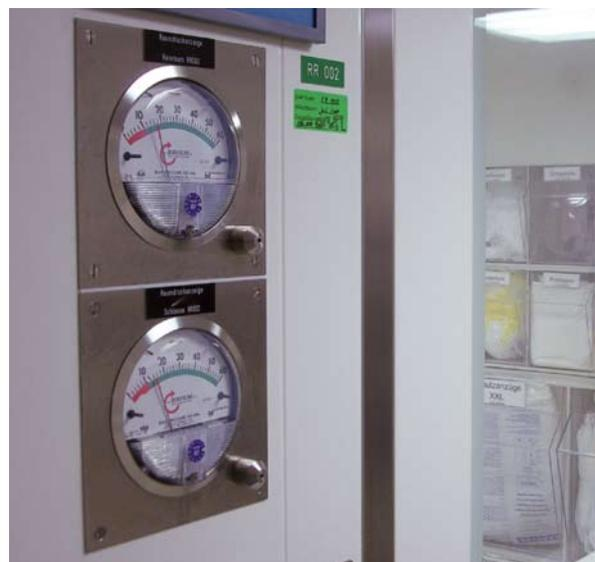
Schleusen Differenzdruck-Überwachung mittels Volumenstromregelung. Innen- und Aussendruck.
